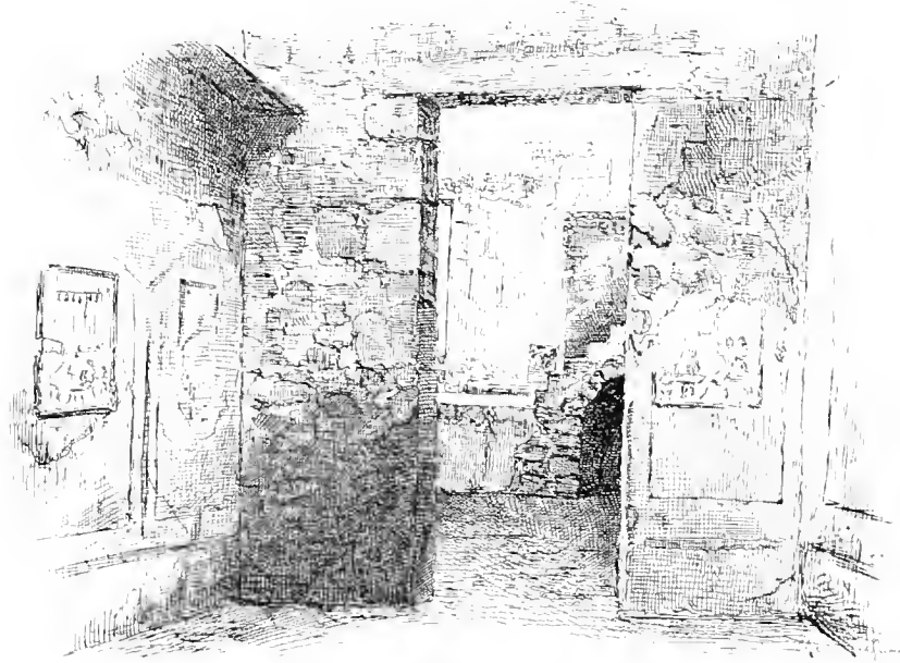
Intérieur de la thermopole de la rue de Mercure.
